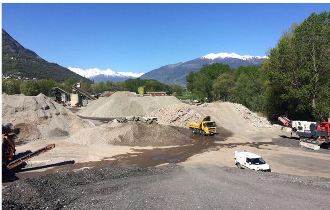
Impianto Rival Srl
